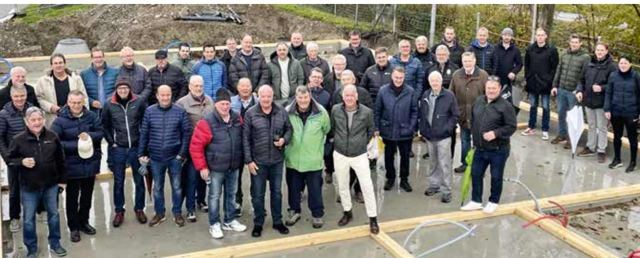
Die Ehemaligen bei der Baustellenbesichtigung unter Führung von Hans Rothen .
