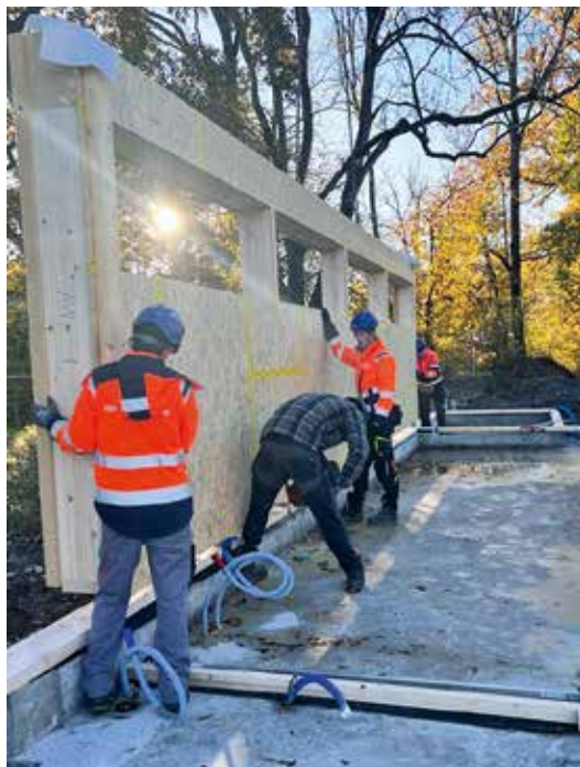
Der Holzbau: Fertigelemente werden angeliefert und sofort verbaut.
